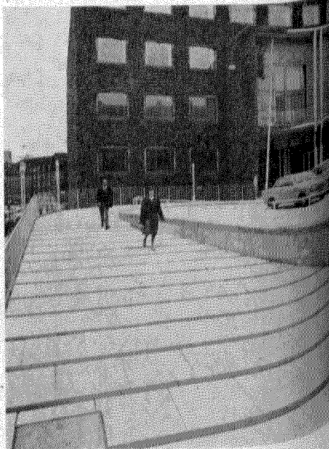
Terrazzoslebne Synopalbetonfliser udlagt på Aarhus Rådhusplads
