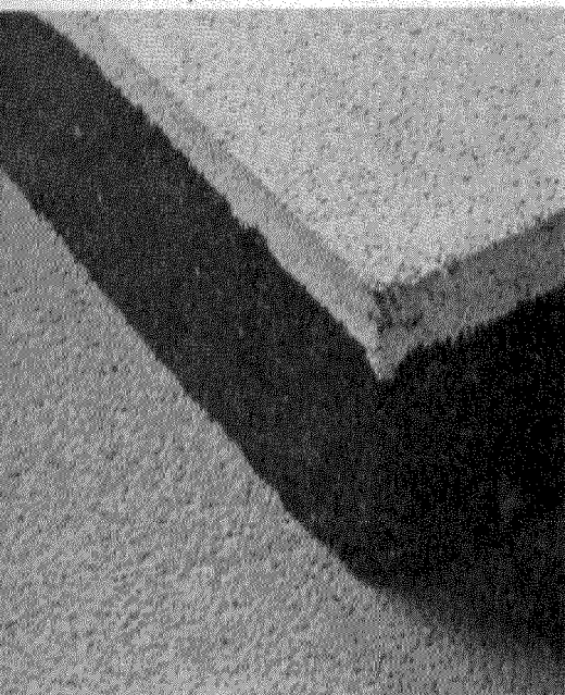
Fortovsfliser til Hamburg, fremstillet med en 2 cm hvid forstøbning af SYNOPAL 0—2 mm og hvid cement
